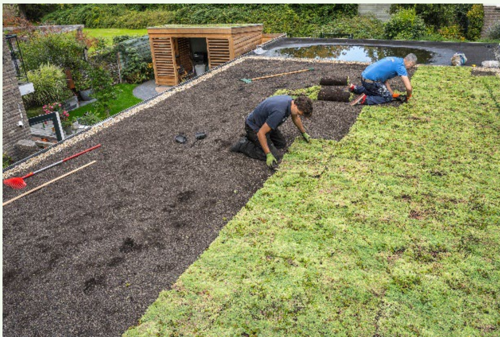
Figuur 4 Aanleg groen dak
